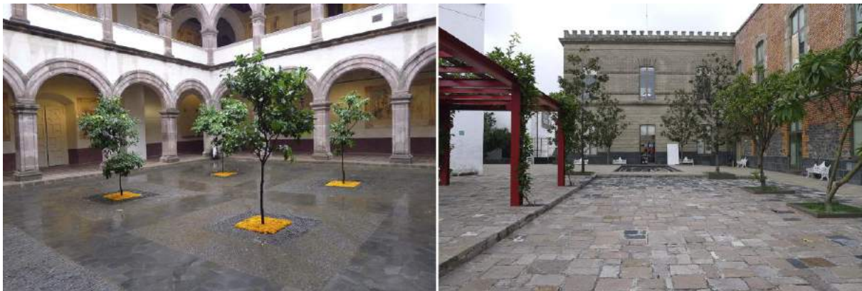
Figura 18: Restauración del claustro del antiguo convento franciscano de santa Ana, Tzintzuntzan, Michoacán, proyecto de Saúl Alcántara y Salvador Aceves.
