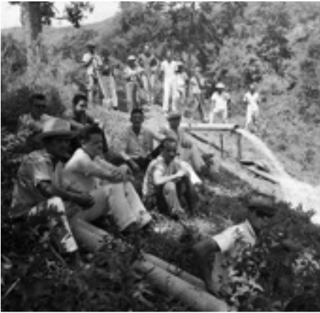
Foto 1: 1969-1970-1971. 02 | 00 | 02. Chegada Canos s/ Água Const. Rede Adutora.
